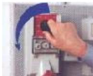
Togliere tensione al sezionatore di linea e scollegare il cavo di alimentazione della pressa.Fig. 2
